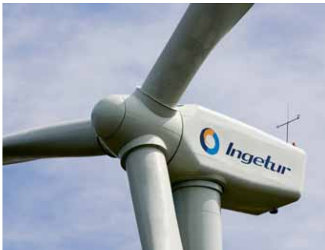
El diàmetre de rotor dels 33 aerogeneradors del parc és de 77 metres.
