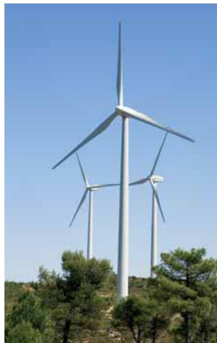
Els aerogeneradors tenen una altura de 80 metres, amb un pes unitari de 195 tones.
