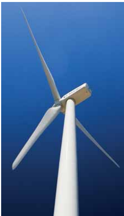
Els aerogeneradors tenen una altura de 80 metres, amb un pes unitari de 195 tones.
