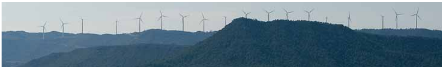
Els aerogeneradors tenen una altura de 80 metres, amb un pes unitari de 195 tones.
