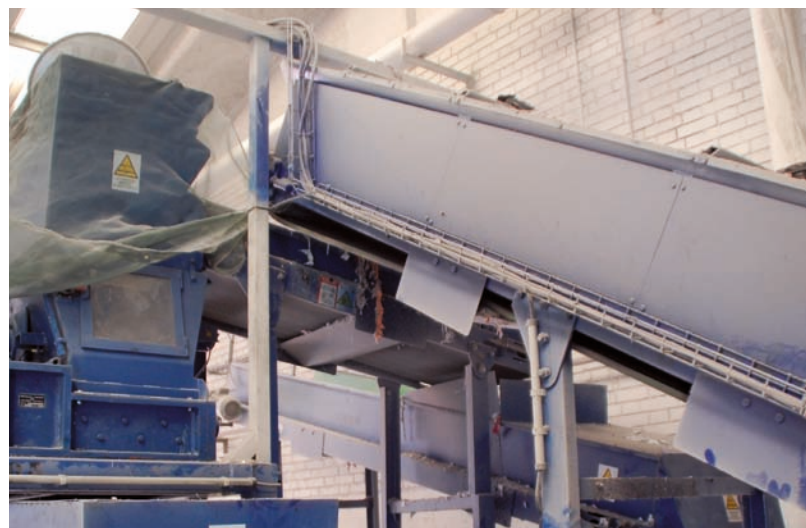
Foto 5: Zona de destrucción confidencial.
