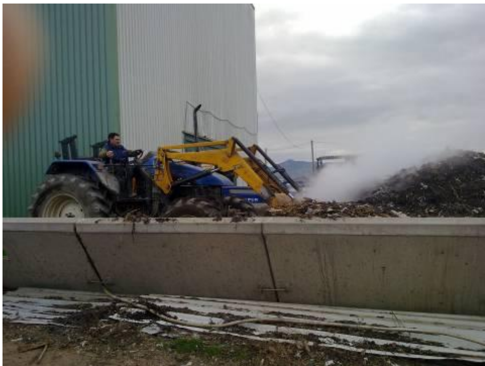
Figura 10. Desmuntatge de les piles
