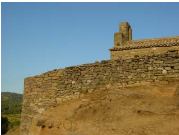
Mur 1. Aspecte d'aquesta estructura al sector B
