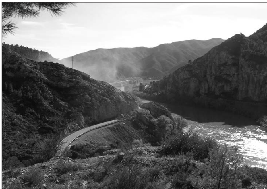
Figura 3. Vista general de les obres de la carretera, l'any 2002.
