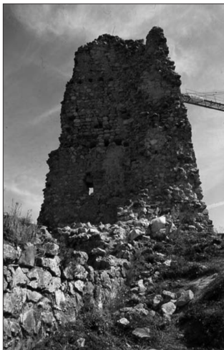
Figura 5. Parament interior de la torre de l'homenatge.
