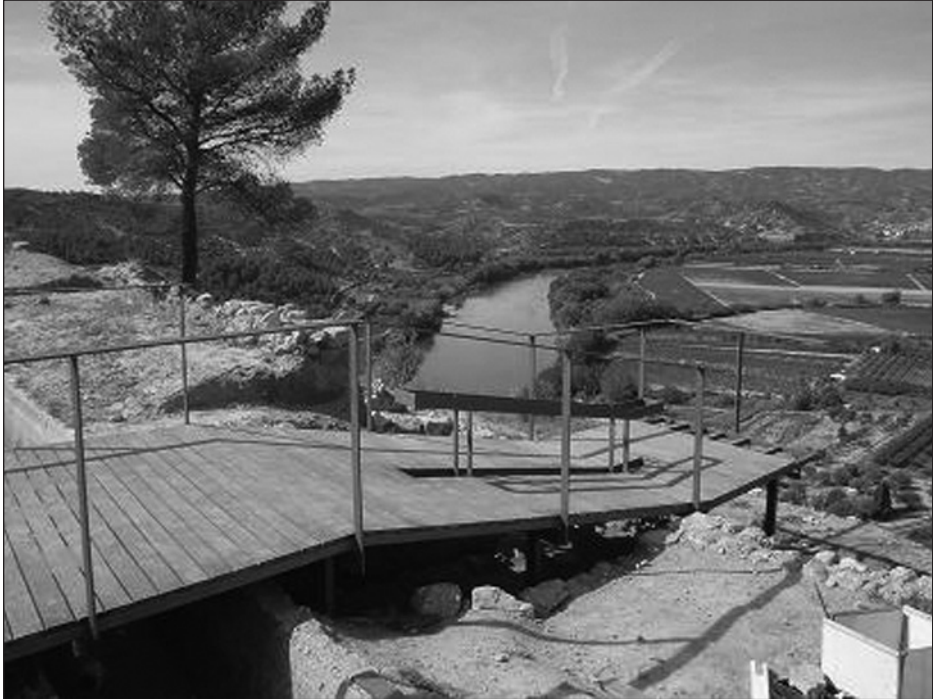
Figura 19. Treball d'adequació de l'establiment de Sant Miquel
