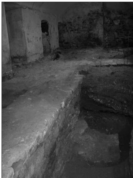
Figura 3. Mur Fet 30 i pilastra espoliada (núm. 5)
