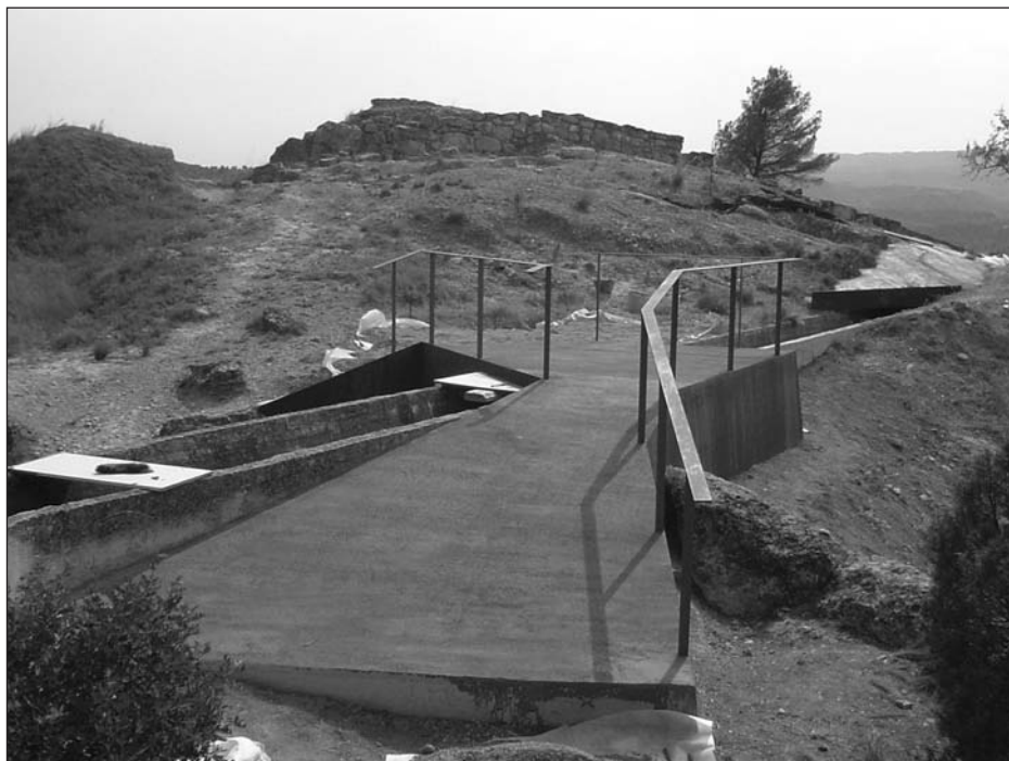
Figura 18. Treball d'adequació de l'establiment de Sant Miquel
