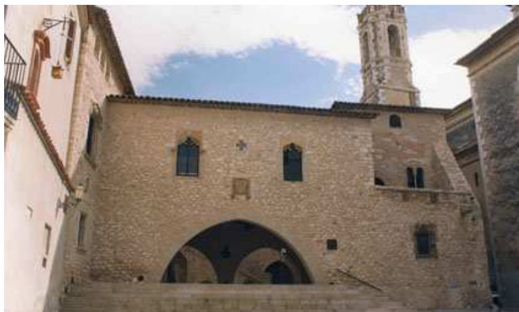
Façana de l'Arxiu Comarcal del Garraf
